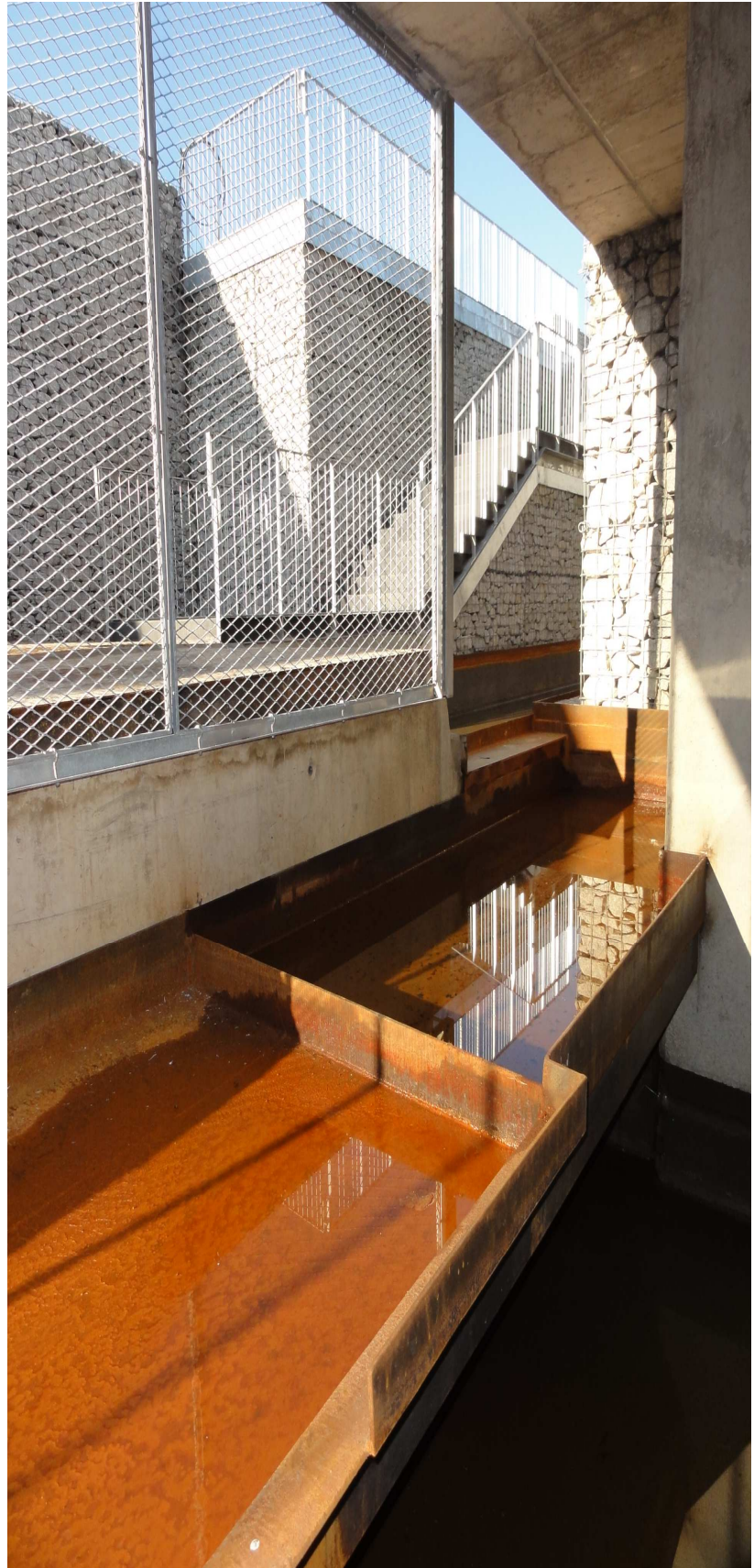
Proyecto de ampliación del cementerio municipal. Fase II: Patio I. Galerías 5 y 6. 216 nichos
