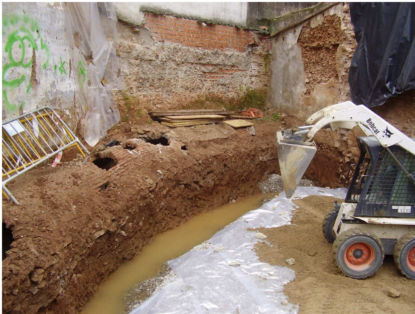
Foto 3. Colector general en solar de Camino Llano
