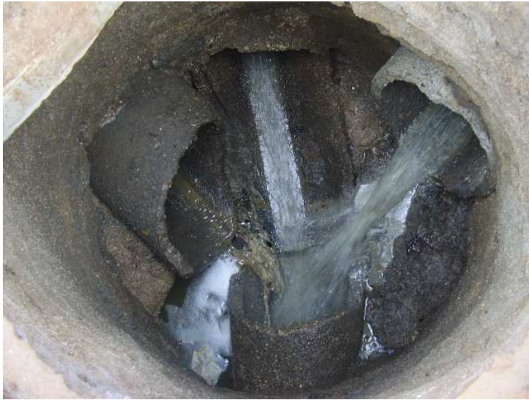
Foto 4. Ejemplo de pozo de registro a renovar
